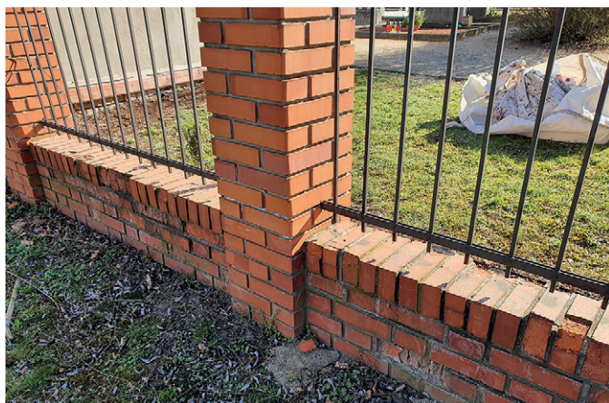
Rekonstrukce hřbitovní zdi
