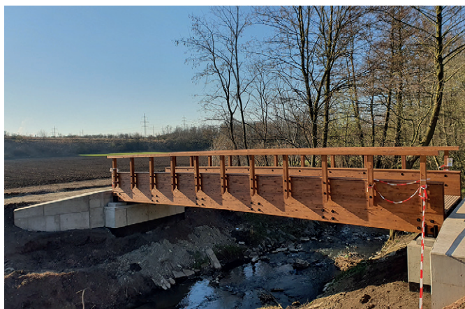
Nový most přes Zlatý potok
