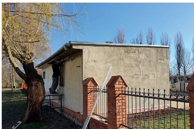
Práce na opravě márnice
