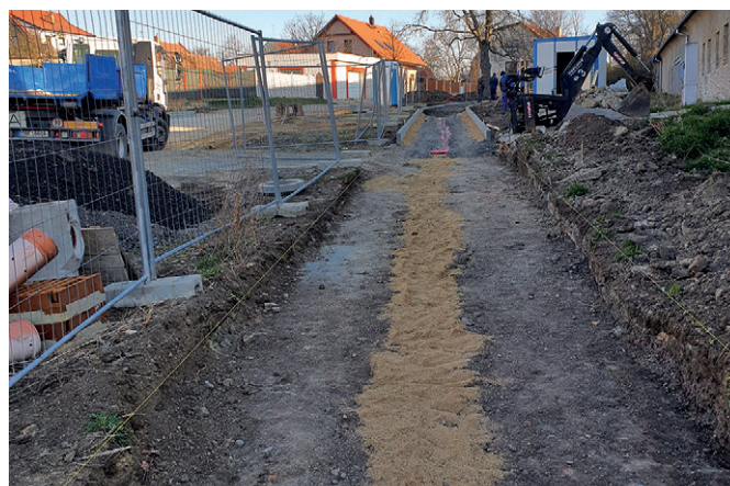
Zámecká ulice – stavební práce
