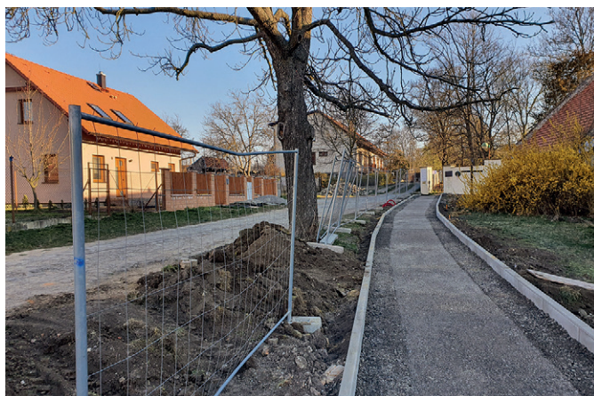
Zámecká ulice – výstavba chodníku
