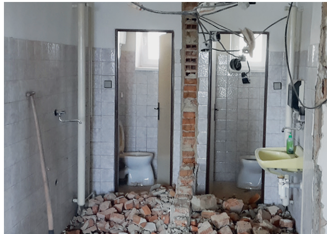
Stavební úpravy toalet 2NP
