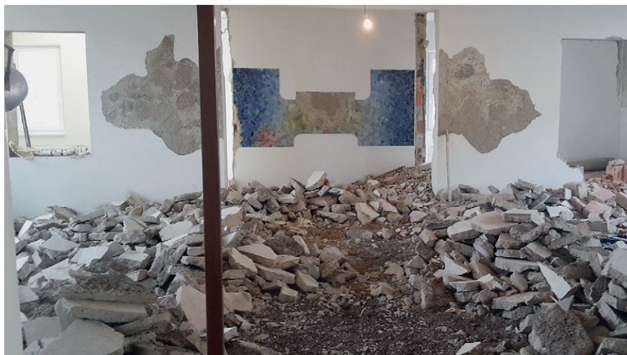
Stavební úpravy v obřadní síni
