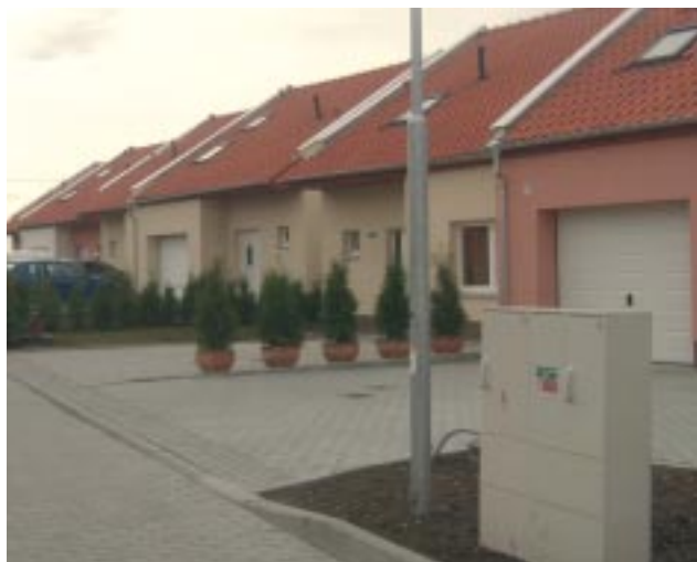
Výstavba rodinných domů – ulice Slovákova
