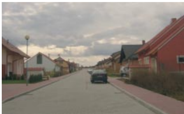
Výstavba rodinných domů – ulice Borky
