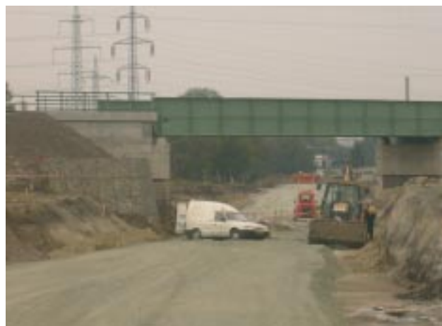
Nový železniční most
