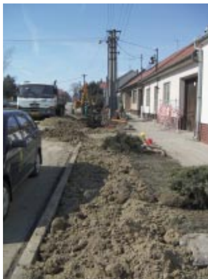
Stavba kanalizace v ulici Komenského
