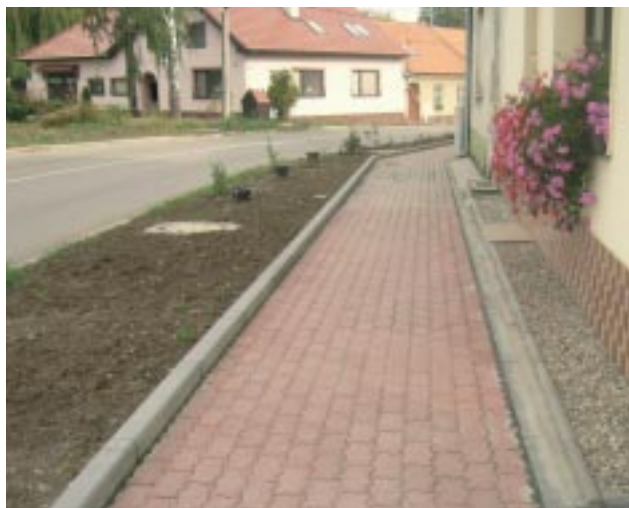
Opravený chodník v ulici Komenského
