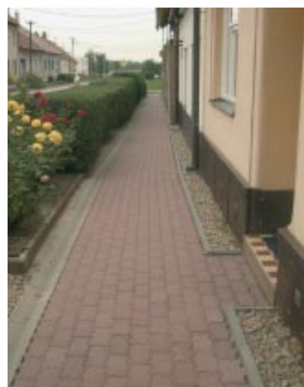
Opravený chodník v ulici Brněnská
