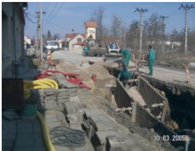
Stavba kanalizace v ulici Kaštanová
