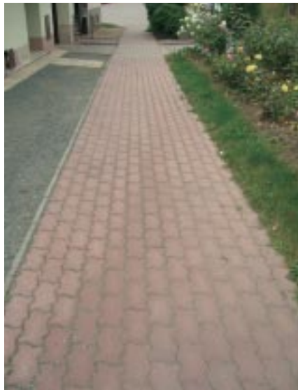
Opravený chodník v ulici Masarykova
